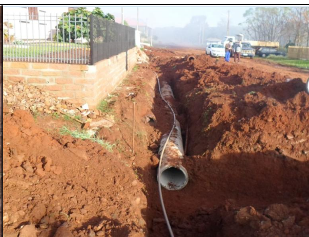
FOTO 02 – Infraestrutura de Drenagem
