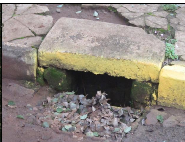
FOTO 04 – Boca de Lobo
